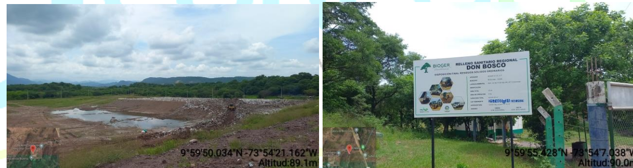
Seguimiento a LA relleno sanitario
